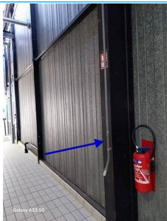
Matériaux : ZPSO-012 Prélèvement : P016 Description : Peinture charpente et IPN (noire et rouge) Localisation : RDC - Circulation 1 Résultat : Absence d'amiante
