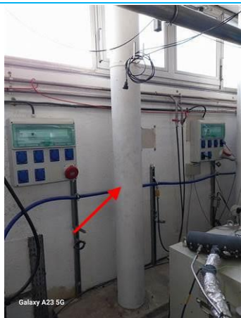
Matériaux : ZPSO-003 Prélèvement : P003 Description : Entourage de poteau (carton-amiante, fibres-ciment, matériau sandwich) Localisation : RDC - Banc d'essai Résultat : Présence d'amiante
