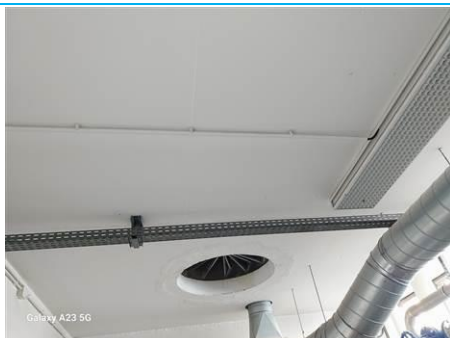
Matériaux : ZPSO-005 Prélèvement : P007 Description : Enduit ciment + peinture Localisation : RDC - Banc d'essai Résultat : Absence d'amiante
