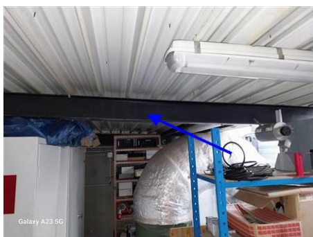
Matériaux : ZPSO-012 Prélèvement : P014 Description : Peinture charpente (noire et rouge) Localisation : R+1 - Zone technique Résultat : Absence d'amiante
