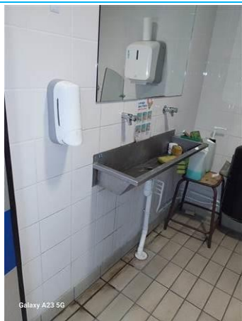
Matériaux : ZPSO-010 Prélèvement : P012 Description : Colle de faïence Localisation : RDC - Sanitaires Résultat : Absence d'amiante
