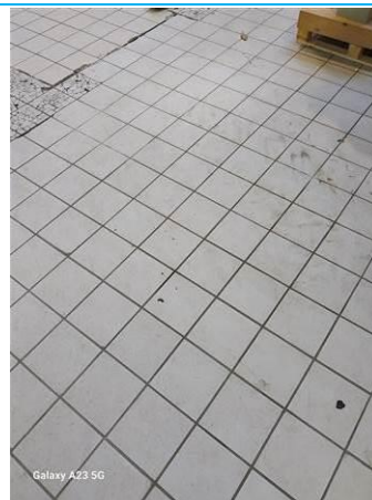
Matériaux : ZPSO-001 Prélèvement : P017 Description : Colle de carrelage Localisation : RDC - Circulation 2 Résultat : Absence d'amiante
