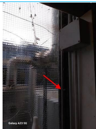
Matériaux : ZPSO-007 Prélèvement : P015 Description : Joint de mastic de vitrage Localisation : RDC - Hall Résultat : Présence d'amiante
