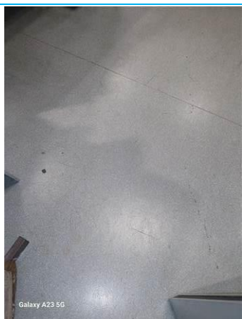
Matériaux : ZPSO-013 Prélèvement : P018 Description : Sous-couche de revêtement souple+ colle Localisation : RDC - Partie bureaux 2 Résultat : Absence d'amiante
