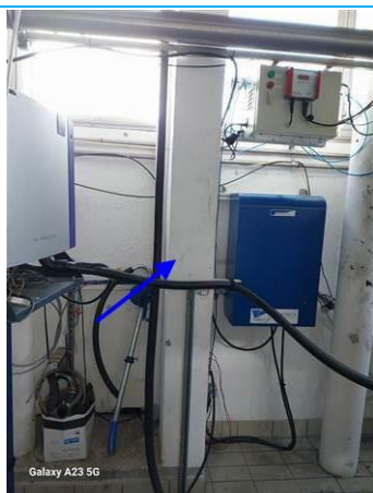
Matériaux : ZPSO-004 Prélèvement : P005 Description : Enduit ciment + peinture Localisation : RDC - Banc d'essai Résultat : Absence d'amiante
