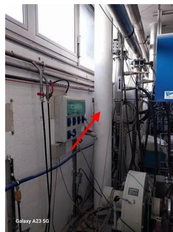
Matériaux : ZPSO-003 Prélèvement : P004 Description : Entourage de poteau Localisation : RDC - Banc d'essai Résultat : Présence d'amiante
